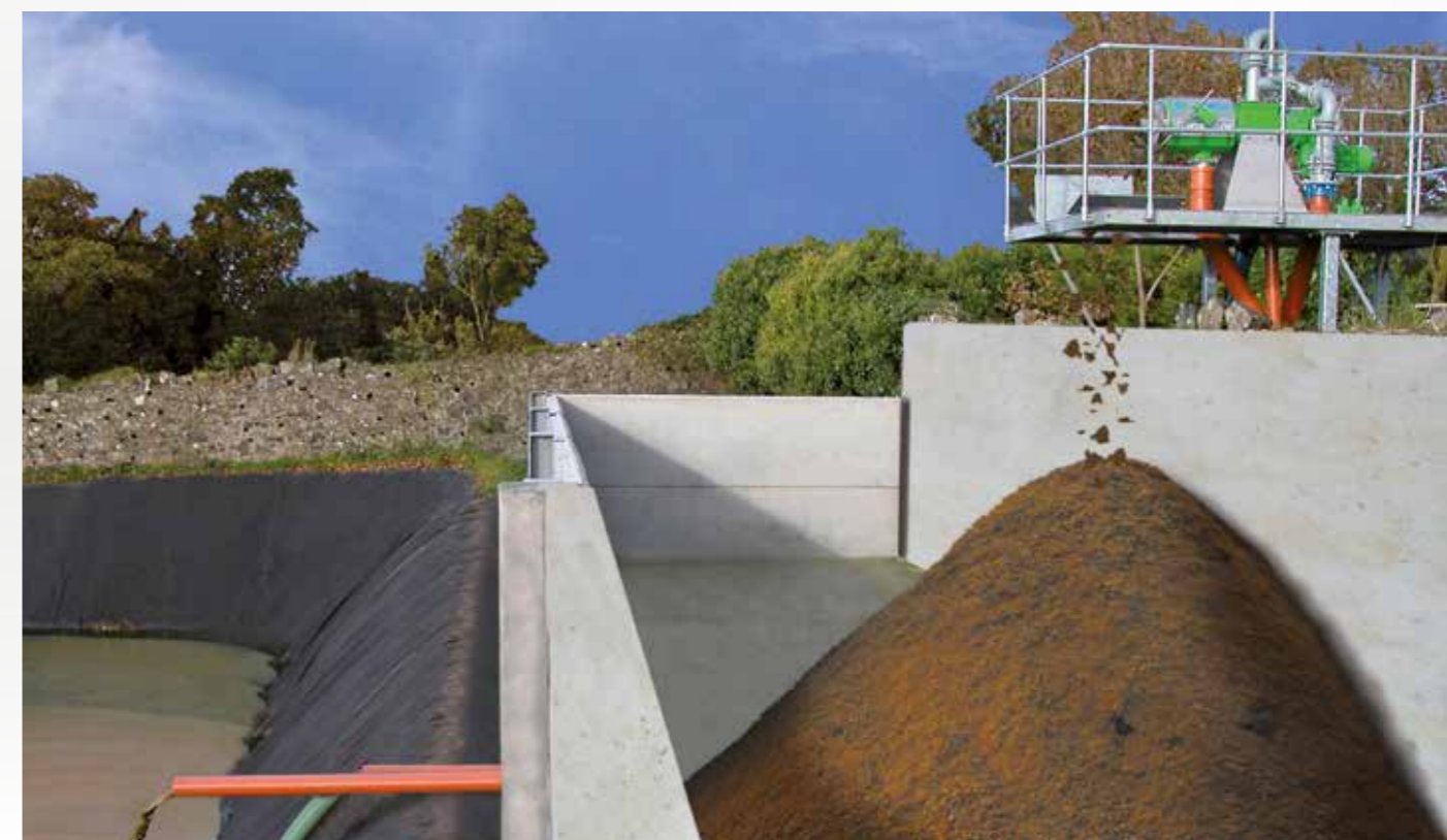
Wiederverwertung von separierter Dünngülle für das Spülsystem
