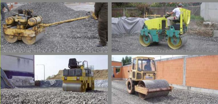
mittelschwere, nicht selbstfahrende und selbstfahrende Walzen
