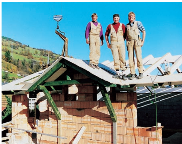
Foto: Holzbau Rainer, Taxenbach
