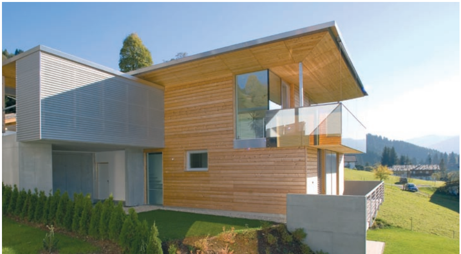
Ein Vordach bietet den nötigen Wetterschutz.
