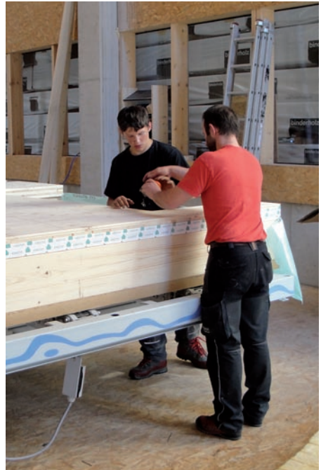
Vorfertigung im Holzbaubetrieb
