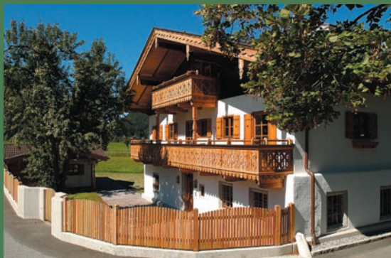
Sanierung in St. Martin. Fotos: Klaus Bauer
